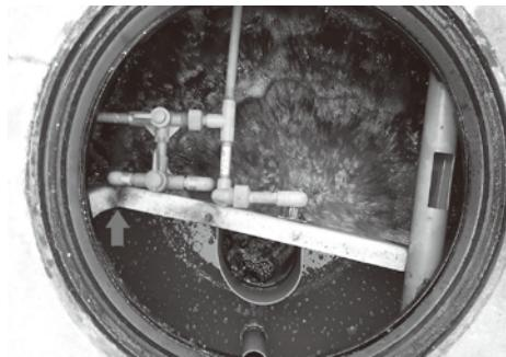
浄化槽の内部仕切り板が土圧で変形しています。(仕切り板の左側が上に動いています。通常は水平。)
