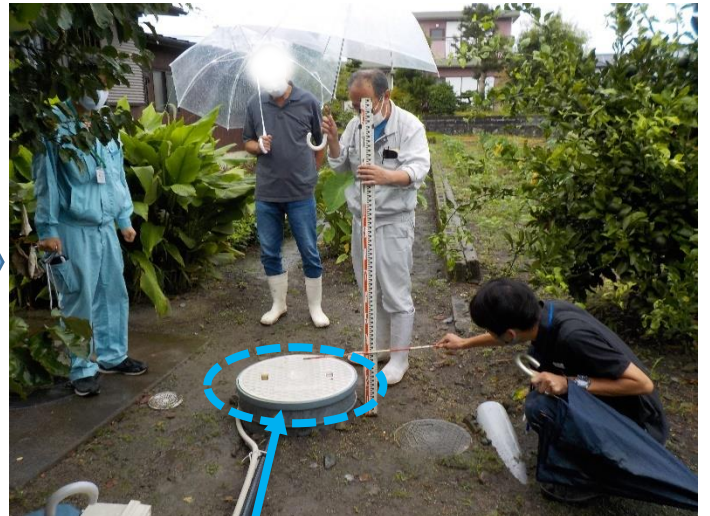
浄化槽用排水ポンプ 槽設置後の現場確認作業状況
