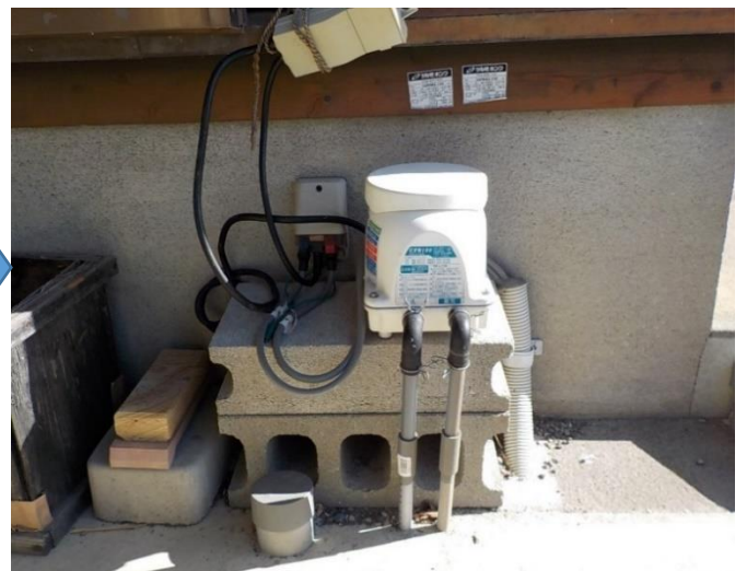
水害時のブロー水没状況 ○ブローの嵩上げは、嵩上げのブロック等を準備していただくと、他の費用は協会が負担いたします。
