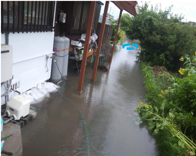
水害時の状況
