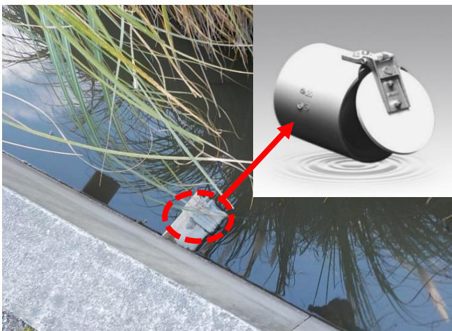
逆止弁取付け状況 放流先に取り付け、増水時水が逆流しない装置
