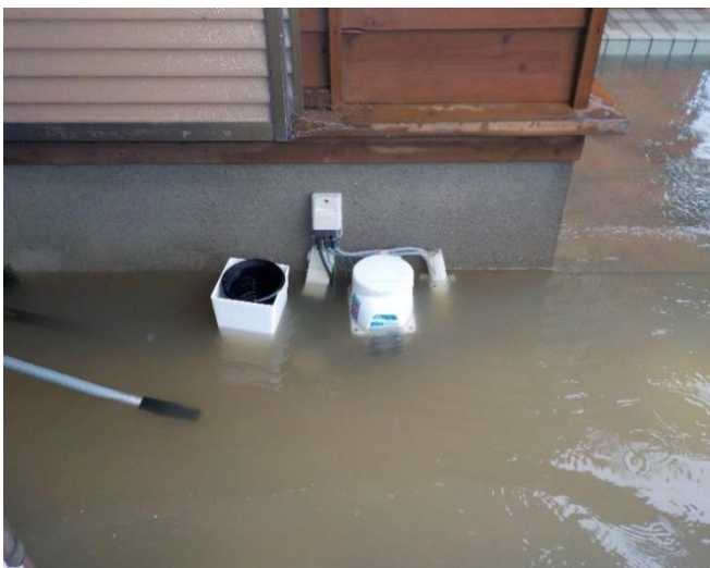
水害時のブロー水没状況 ○ブローの嵩上げは、嵩上げのブロック等を準備していただくと、他の費用は協会が負担いたします。
